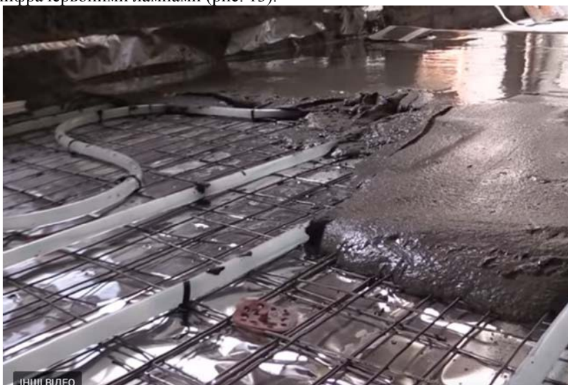
Рисунок 13 - Локальний обігрів в станку для дорощування: облаштування теплої підлоги з підігрівом водою (а) та кришка з інфрачервоними лампами
