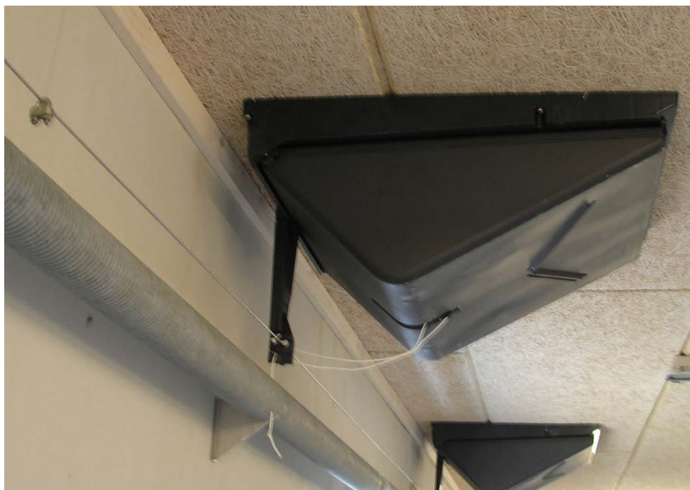
Рисунок 8 – Перфорована стеля з додатковими припливними клапанами
