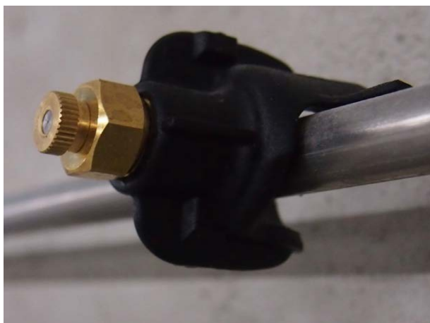
Рисунок 4 – Форсунки зрошення для кондиціювання повітря влітку
