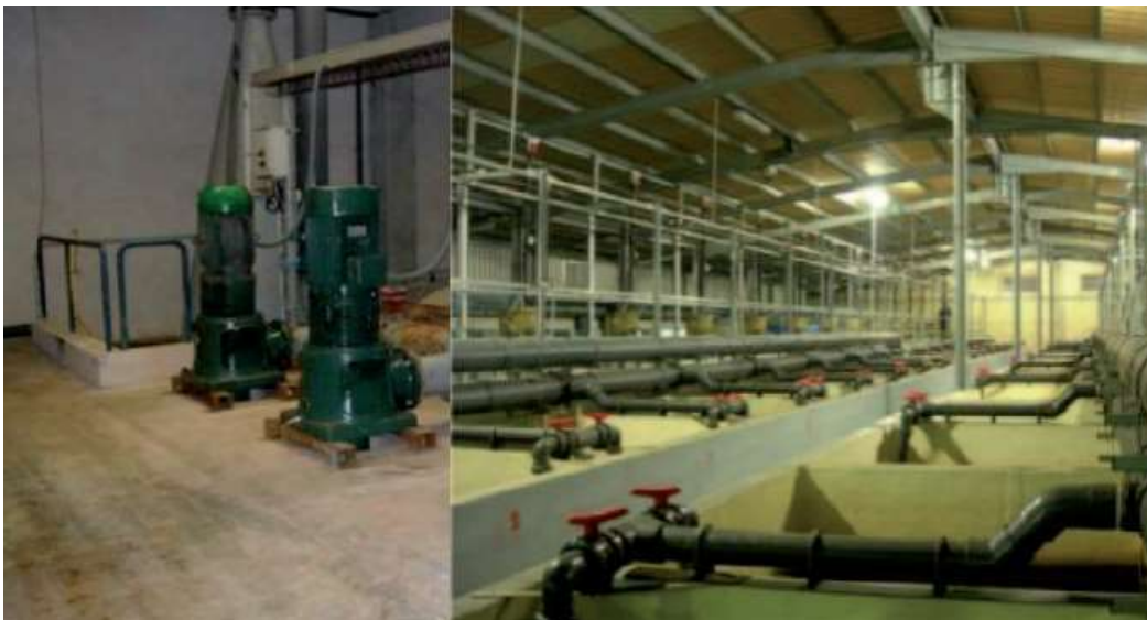
Фото 6: Вертикальні імпульсні насоси (ліворуч) і виробниче приміщення з резервуарами та трубопроводами (праворуч) © Rodolfo Barrera
